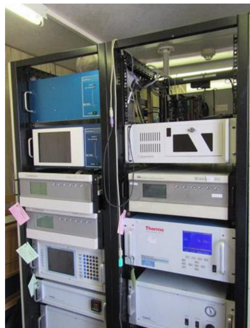
Σχήμα 2: Αντιπροσωπευτικός Σταθμός Παρακολούθησης του Ατμοσφαιρικού Αέρα. Figure 2: Representative Air Quality Monitoring Station.
